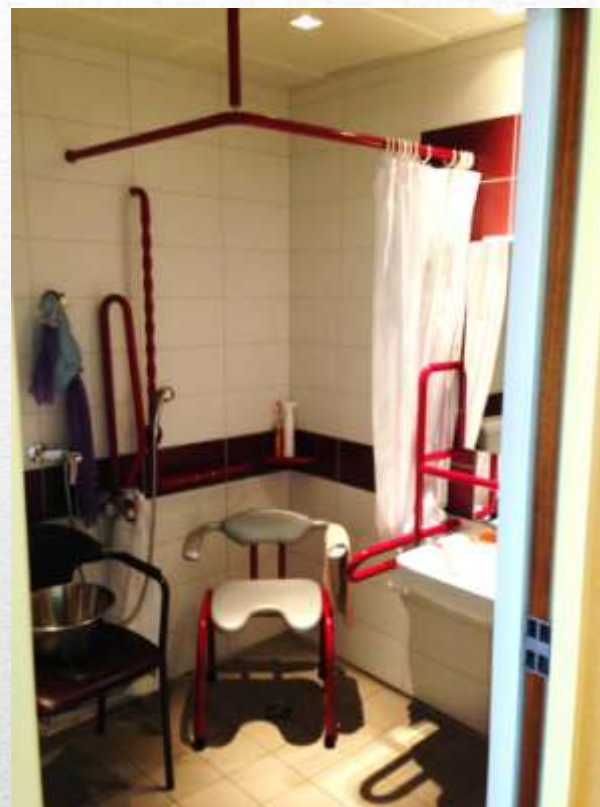
Salle-de-bain – 4 points lumineux et des barres d'appui
