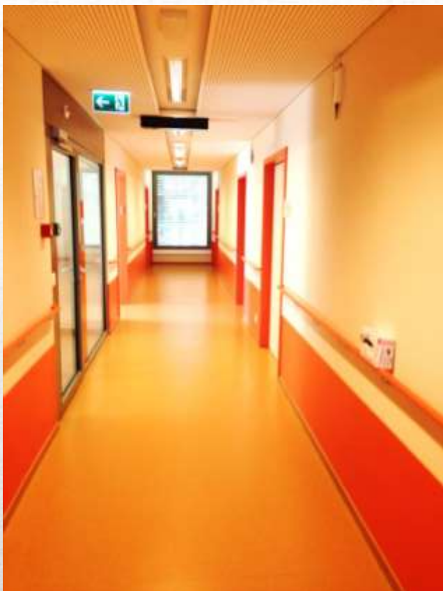
Couloir – Lumière et contre jour. Sans reflets
